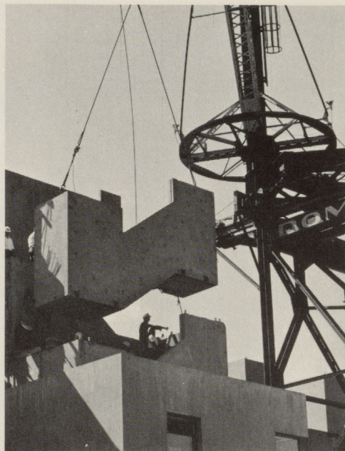
Assembly of an escape stair tower. Assemblage d'une cage d'escalier de service.
