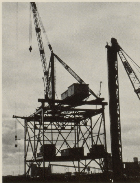
The stiff leg crane on site prior to the placing of the first box. La grue géante attend, au repos, qu'une première "boîte" soit terminée pour la mettre en place.
